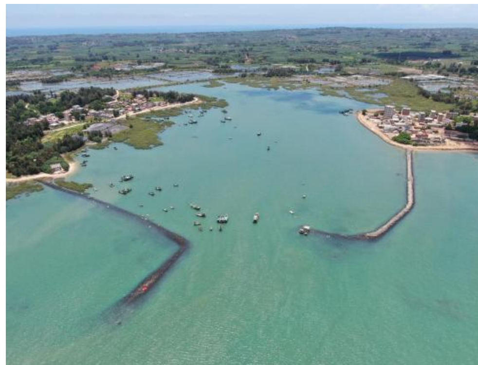
图 2.6-12 硇洲中心渔港（北港）现状照片
