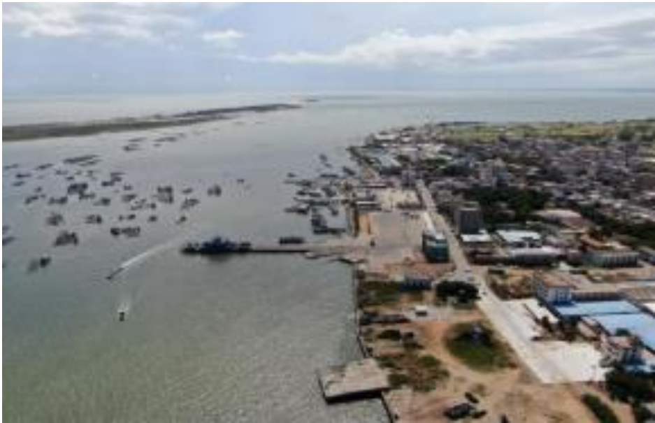
图 2.6-6 东南渔港现状照片
