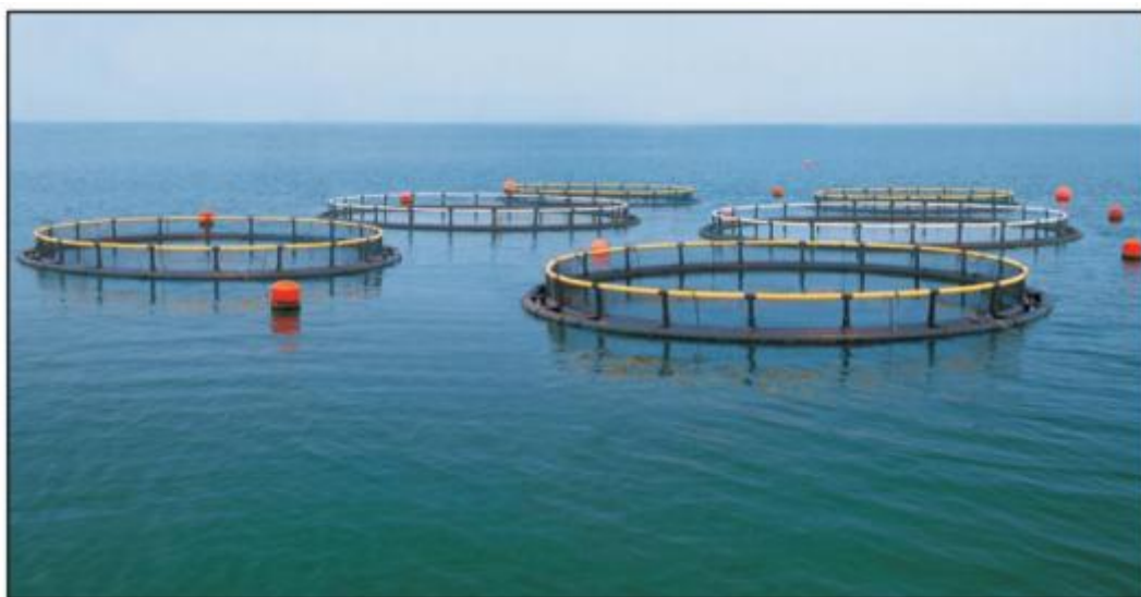
图 2-5 深水网箱框架系统示意图
