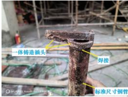
图 10 现场使用的完好水平杆端插销图
