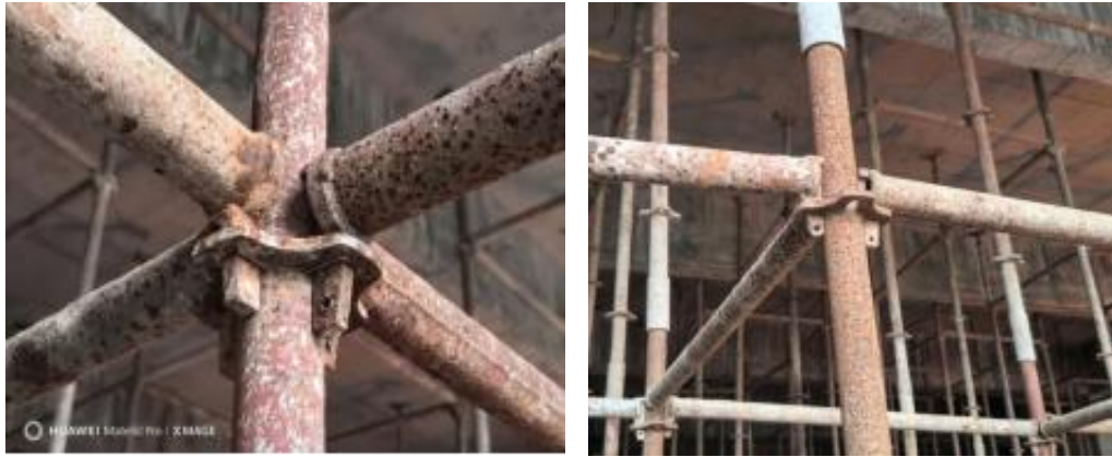
图 8 现场使用钢管模板支撑架盘扣节点
