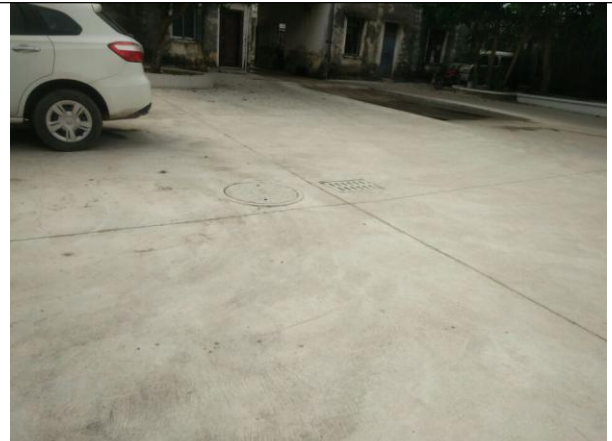
项目出口洗车池
