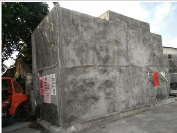
项目污水处理站
