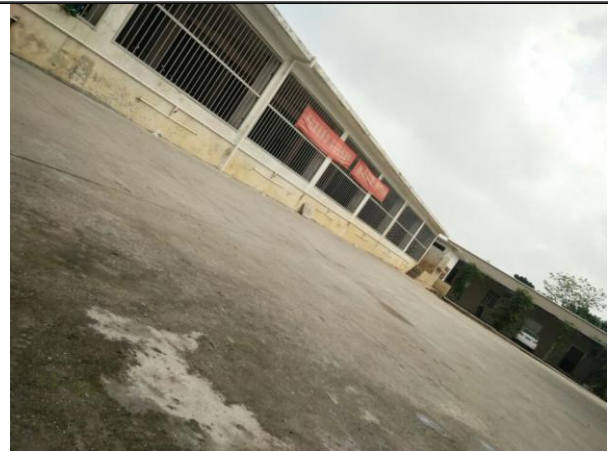
待宰栏排水沟
