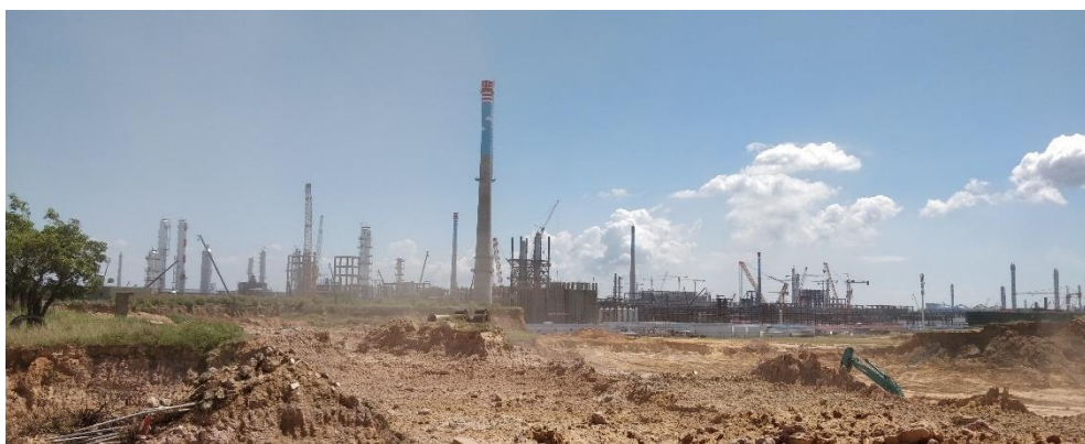
项目北侧距中科炼化约 30m
