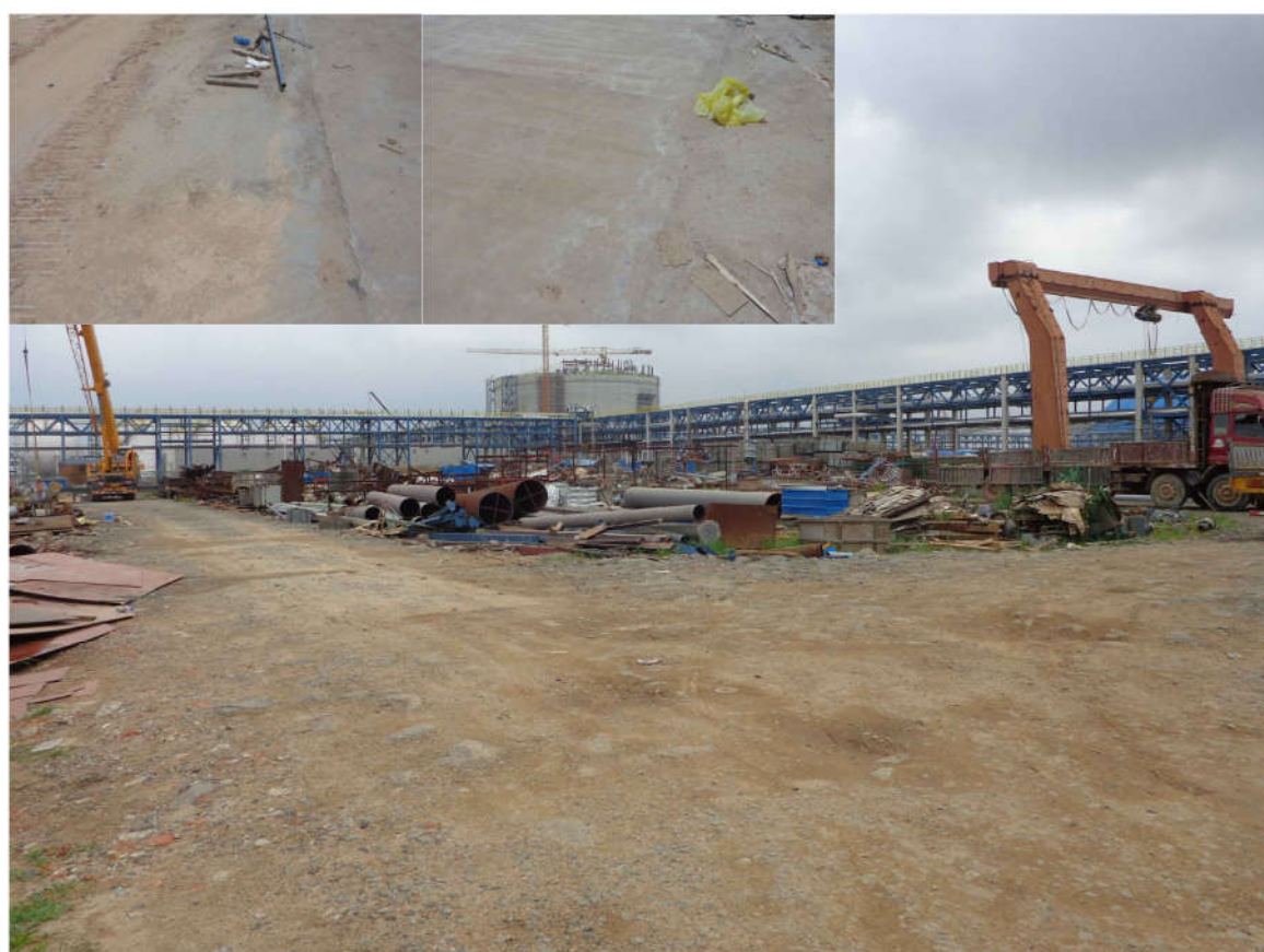
图 5 项目所在区域现场照片
